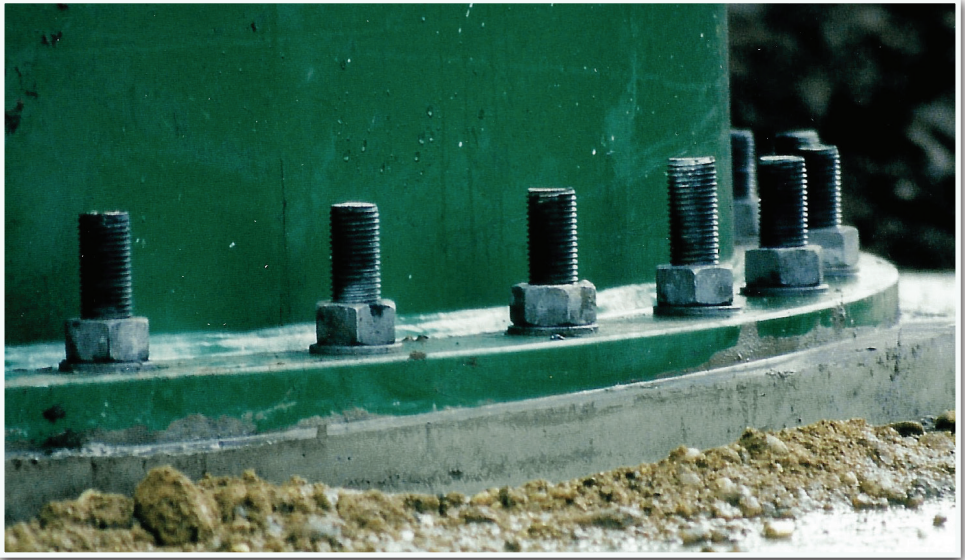
1997 - Befestigung des Turms am Fundament
