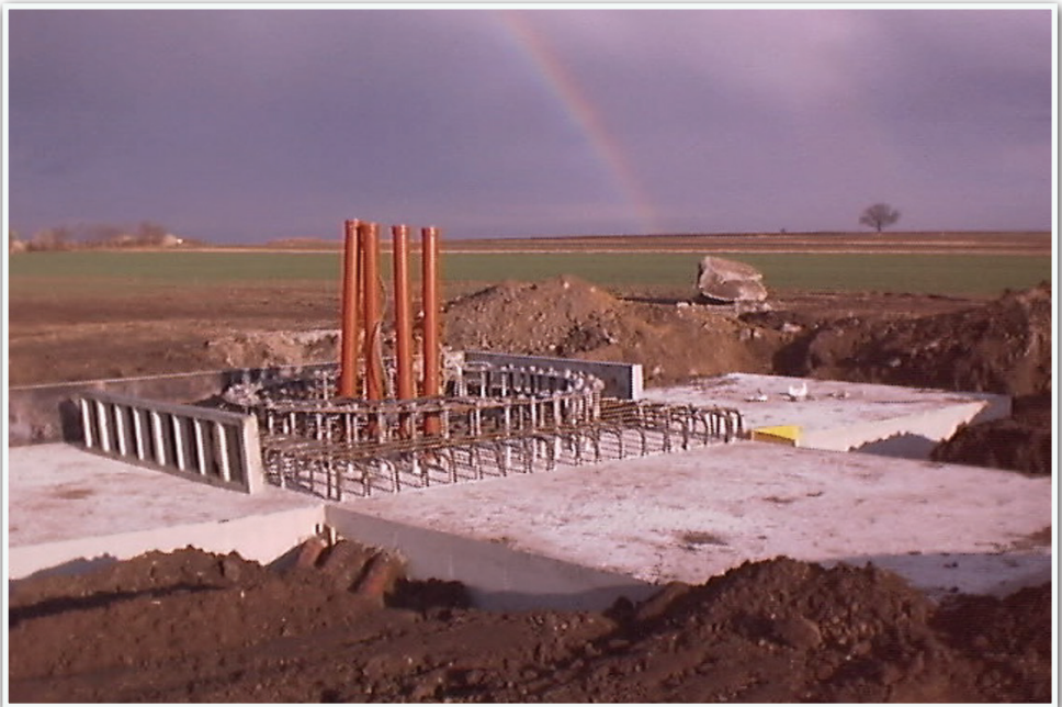
1997 - Errichtung des Fundaments
