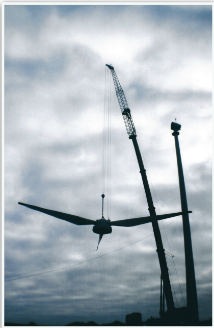
1997 - Nabe mit Rotorblätter wird angehoben
